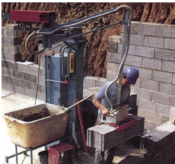
Esempio: macchina per la posa dei mattoni
